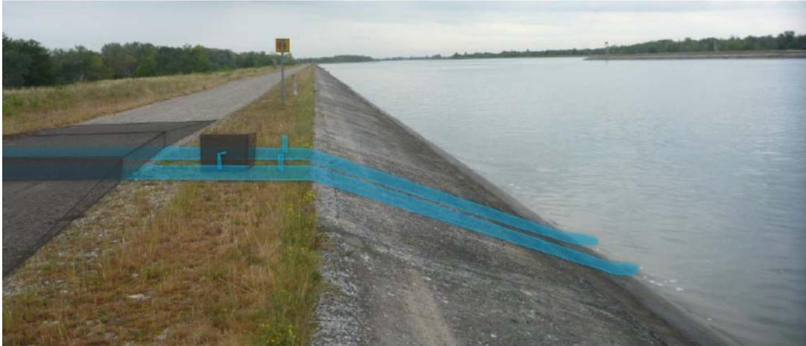
Die Entnahmestelle wird zwei Meter von der Fahrrinnengrenze entfernt liegen und eine Wassereutnahme von maximal 2 m<sup>3</sup>/s gewährleisten.
