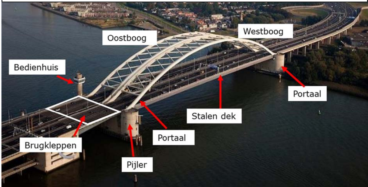
Vue d'ensemble du pont de Van Brienenoord
