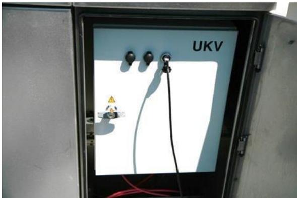
Innenansicht des offenen Anschlusschanks mit den drei LAN-Anschlüssen (pro Fahrgastschiff), wovon einer in Betrieb ist.
