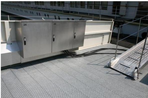
Der schmale Anschlussschrank (jeweils wasser-seitig) beinhaltet drei LAN-Anschlüsse für den kostenfreien Internetzugang für ein Fahrgastschiff.
