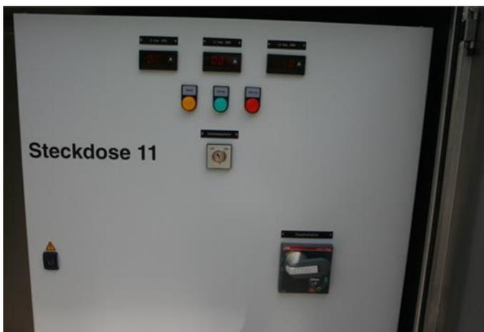
Die Anschlussschränke mit den Powerlock-Stationen befinden sich am unteren Ende links und rechts auf den Landstegen. In den beiden breiten E-Schränken befinden sich jeweils die Steckdosen der zwei Powerlock-Stationen für ein Fahrgastschiff ( $2 \times 400 \text{ A}$ ).
