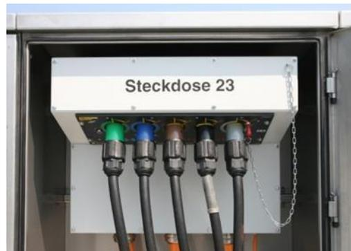
Genormten Powerlock-Kabel in der richtigen Reihenfolge von links nach rechts.
