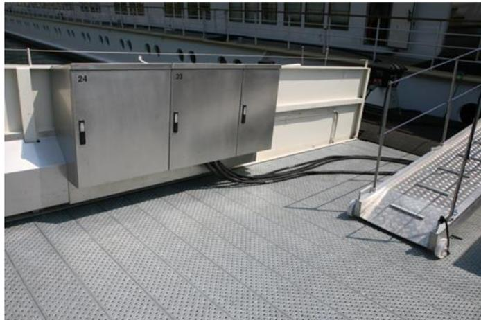
Durch diese Anordnung sind die Besatzungen nicht gezwungen, lange und schwere Verbindungskabel zu verlegen. Bei Doppelbelegung der Anlegestellen reichen die Verlängerungskabel in ihrer Länge aus, damit der Aussenlieger ebenfalls den Landstromanschluss erstellen kann.
