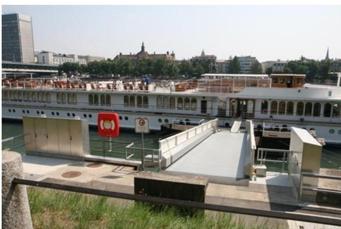
Für jedes Fahrgastschiff stehen zwei Powerlock-Stationen mit je  $2 \times 400 \text{ A} = \text{TOTAL } 800 \text{ A}$  zur Verfügung.
