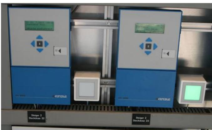
Freischaltung des Landstroms durch Stromimpulszähler im Schrank Kostenverteiler.
