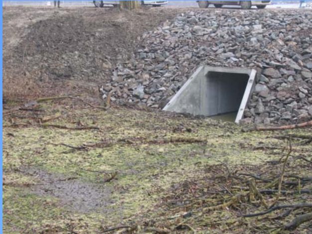
Ouvrage de prise D'eau sur le Rhin
