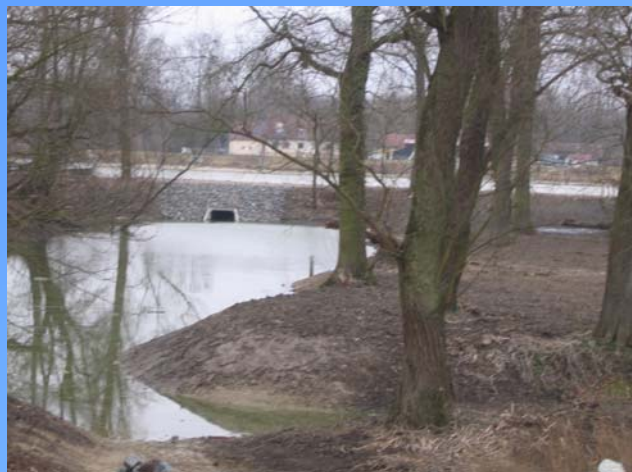
Ouvrage de prise D'eau sur le Rhin
