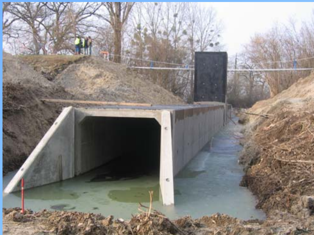
Ouvrage sur DHE
